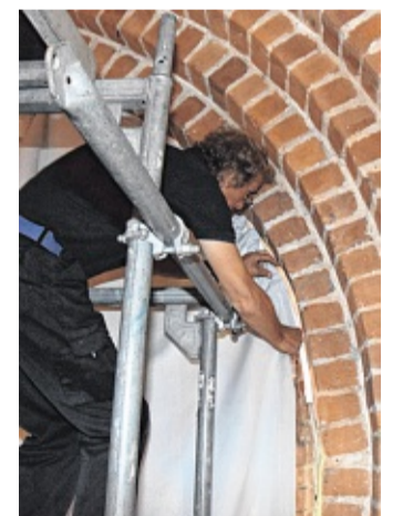
Georg Schütte montiert die gebogenen Alu-Schienen.
