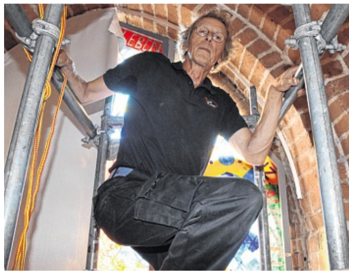
Georg Schütte an seinem Arbeitsplatz in zehn Metern Höhe.
